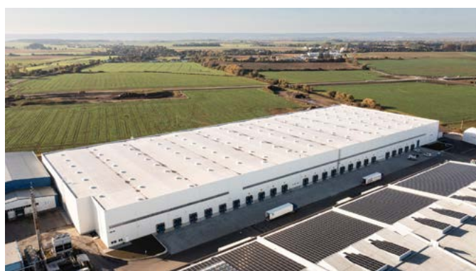
Střecha skladu v budoucnu umožní instalaci solárních panelů.
